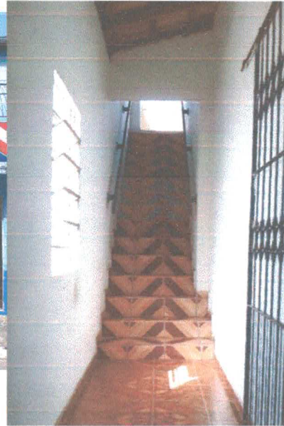
Figura 03 – Escada De Acesso Do 2º Pavimento
