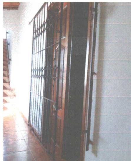
Figura 04 - Porta De Acesso Ao Primeiro Pavimento
