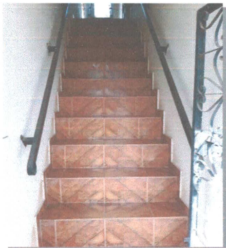
Figura02 – Escada De Acesso Ao 1º Pavimento
