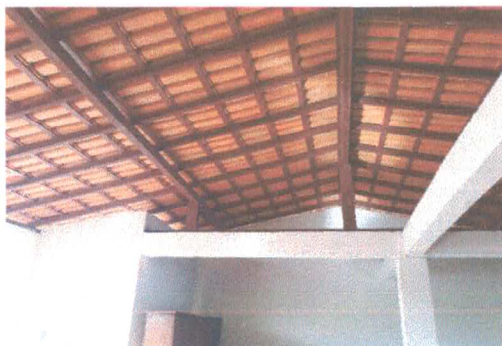
Figura 14 - Estrutura de Cobertura
