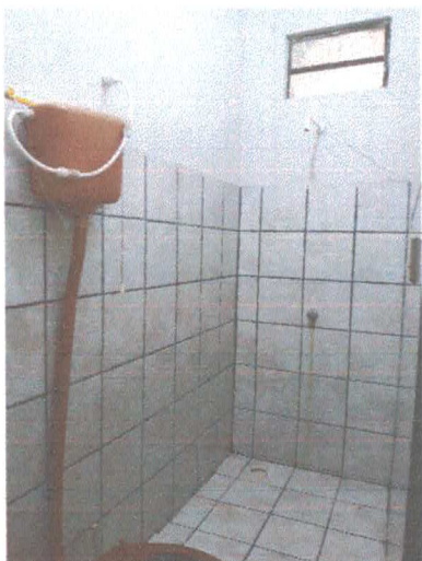
Figura 21 – Banheiro Primeiro Pavimento
