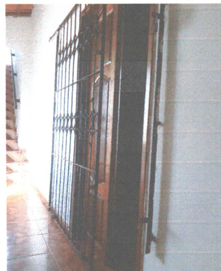
Figura 04 - Porta De Acesso Ao Primeiro Pavimento
