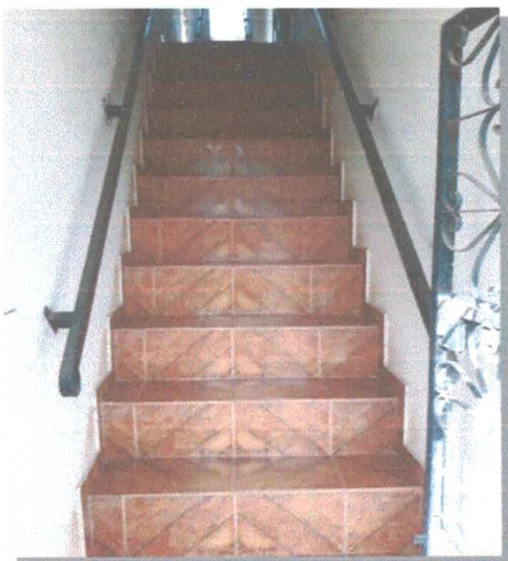
Figura02 – Escada De Acesso Ao 1º Pavimento
