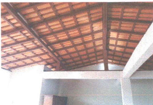
Figura 14 - Estrutura de Cobertura
