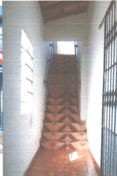
Figura 03 – Escada De Acesso Do 2º Pavimento
